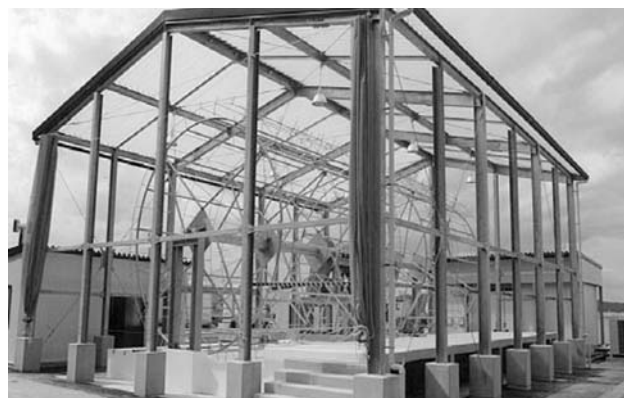
塩釜市浦戸支所 ノリ陸上採苗施設
