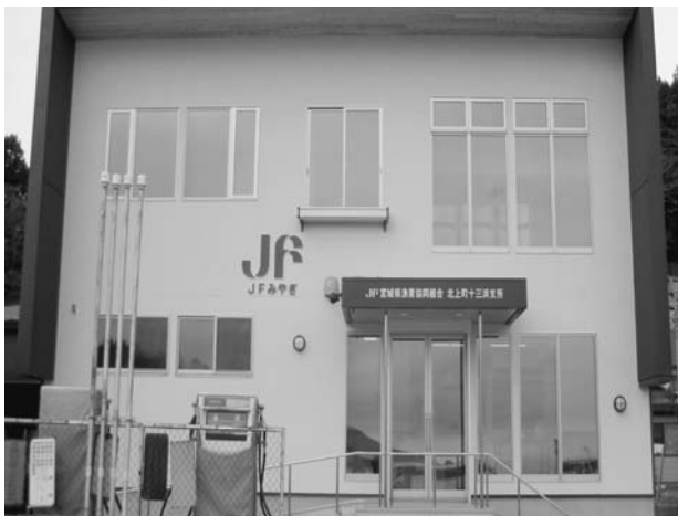
完成した十三浜支所事務所
