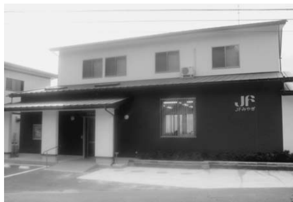
完成した石巻地区支所事務所
